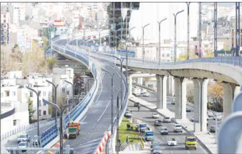
افتتاح پل طبقاتی صدر- آذر ۱۳۹۲ / عکاس: مرفیه موسوی
